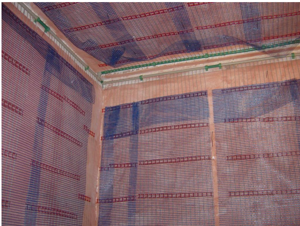
Obr. 2 Montáž kapilárneho systému na steny a strop miestnosti
